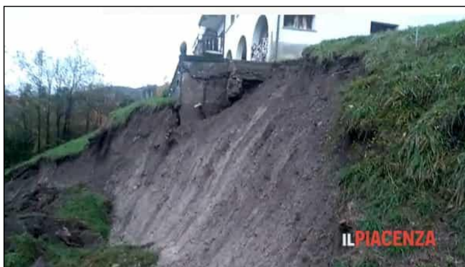
Figura 57: Frana a Vaio di Centenaro (foto ilpiacenza.it del 25/11).
