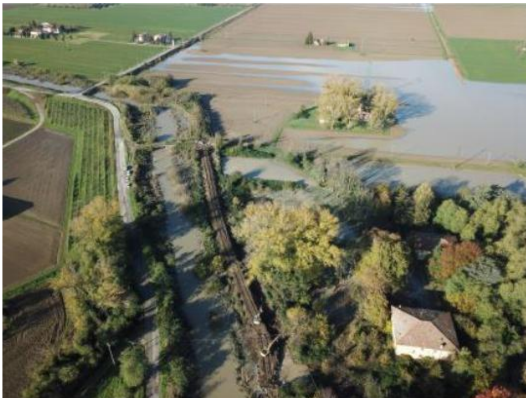
Figura 43: Rotta arginale in destra Savena abbandonato a Malalbergo (foto del 18 novembre)
