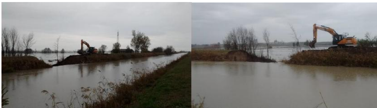
Figura 21: Rotta del Canale diversivo della Burana a Finale Emilia.
