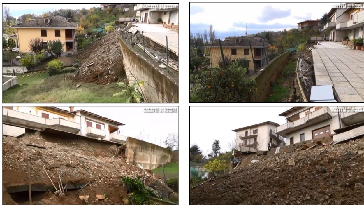
Figura 61: Diverse vedute della frana di Verica in comune di Pavullo nel Frignano (immagini tratte da video Gazzetta di Modena).
