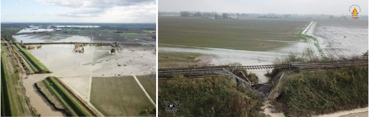
Figura 44: Rotta arginale in destra Idice e conseguente danneggiamento della ferrovia Bologna-Portomaggiore.
