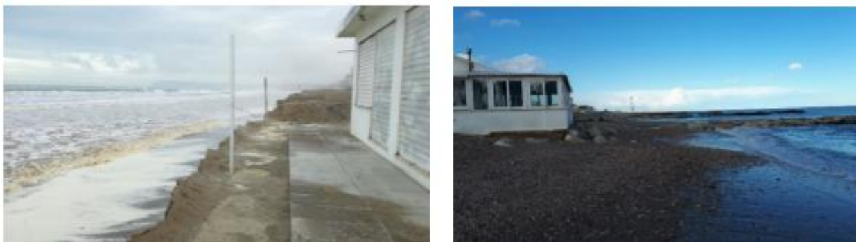
Figura 63: – Erosioni nel Riminese (fonte Protezione Civile)
