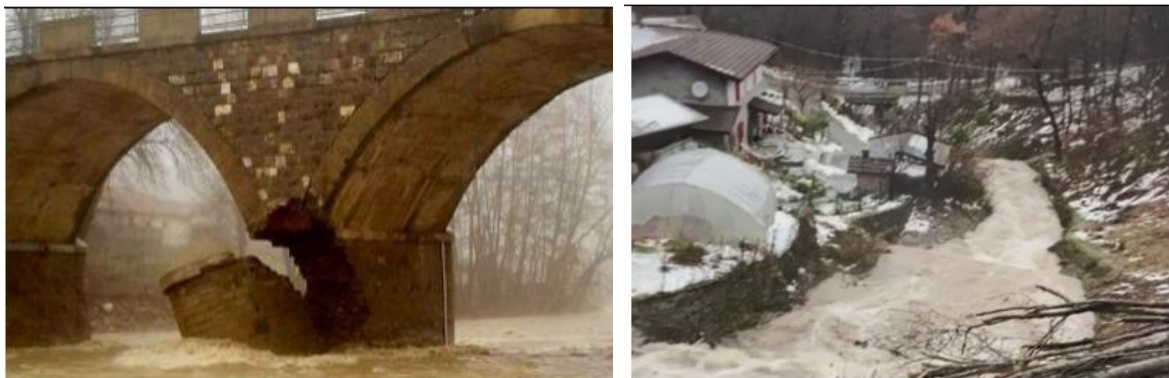
Figura 39: Il danneggiamento di una pila del ponte Samone, a sinistra e i fenomeni erosivi delle sponde destra e sinistra con pericolo di interessamento abitazioni nel comune di Sestola (fonte Protezione Civile)
