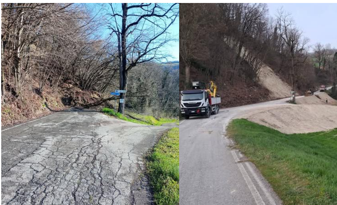
Figura 52: Frana per scivolamento rapido della coltre che ha riversato materiale detritico sulla sede di Strada Antreola, in località Mizzone nel comune di Neviano degli Arduini.
