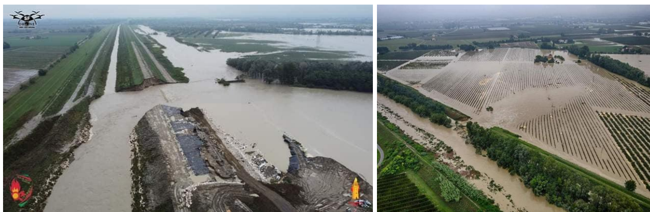
Figura 30: Rotta del fiume Idice a Selva Malvezzi tra Budrio e Molinella (a sinistra – fonte: Vigili del Fuoco) e rotta del fiume Senio a Cotignola (a destra – fonte canale Telegram MeteoRoby)
