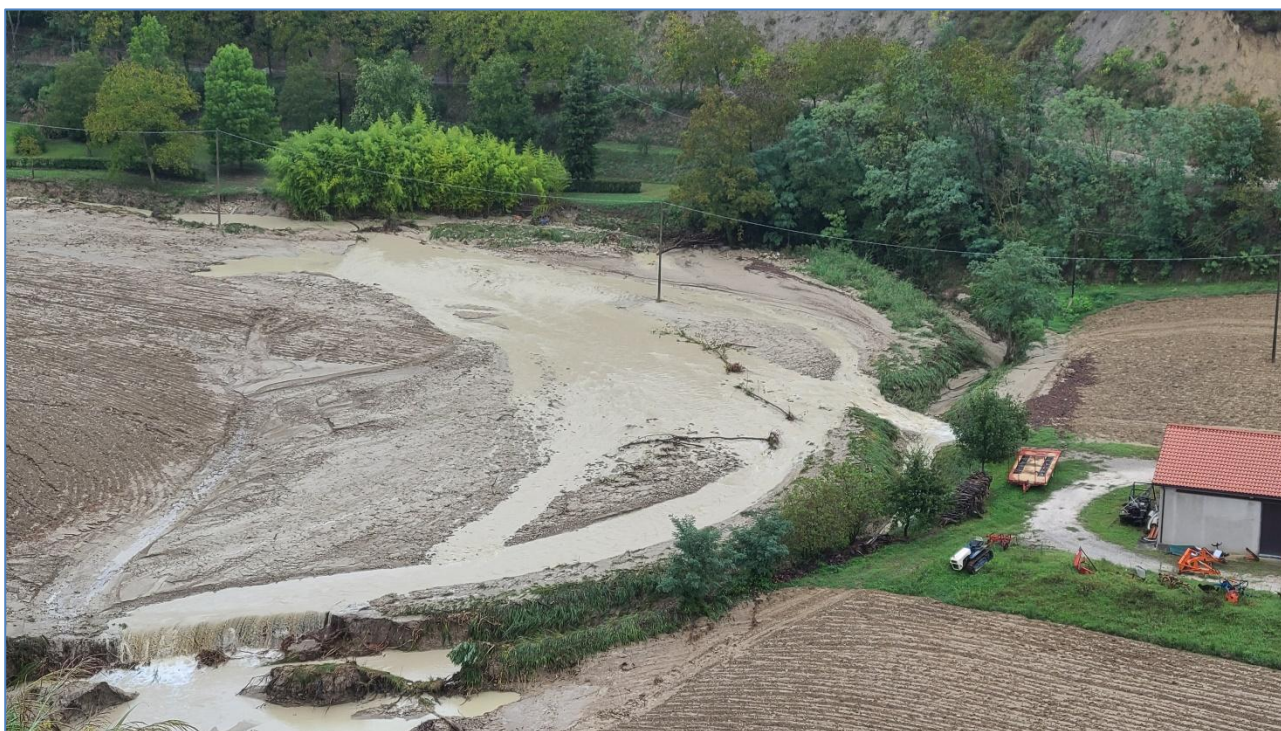
Figura 39: Locale disalveamento del Fosso della Villa, in Comune di Dovadola (FC).
