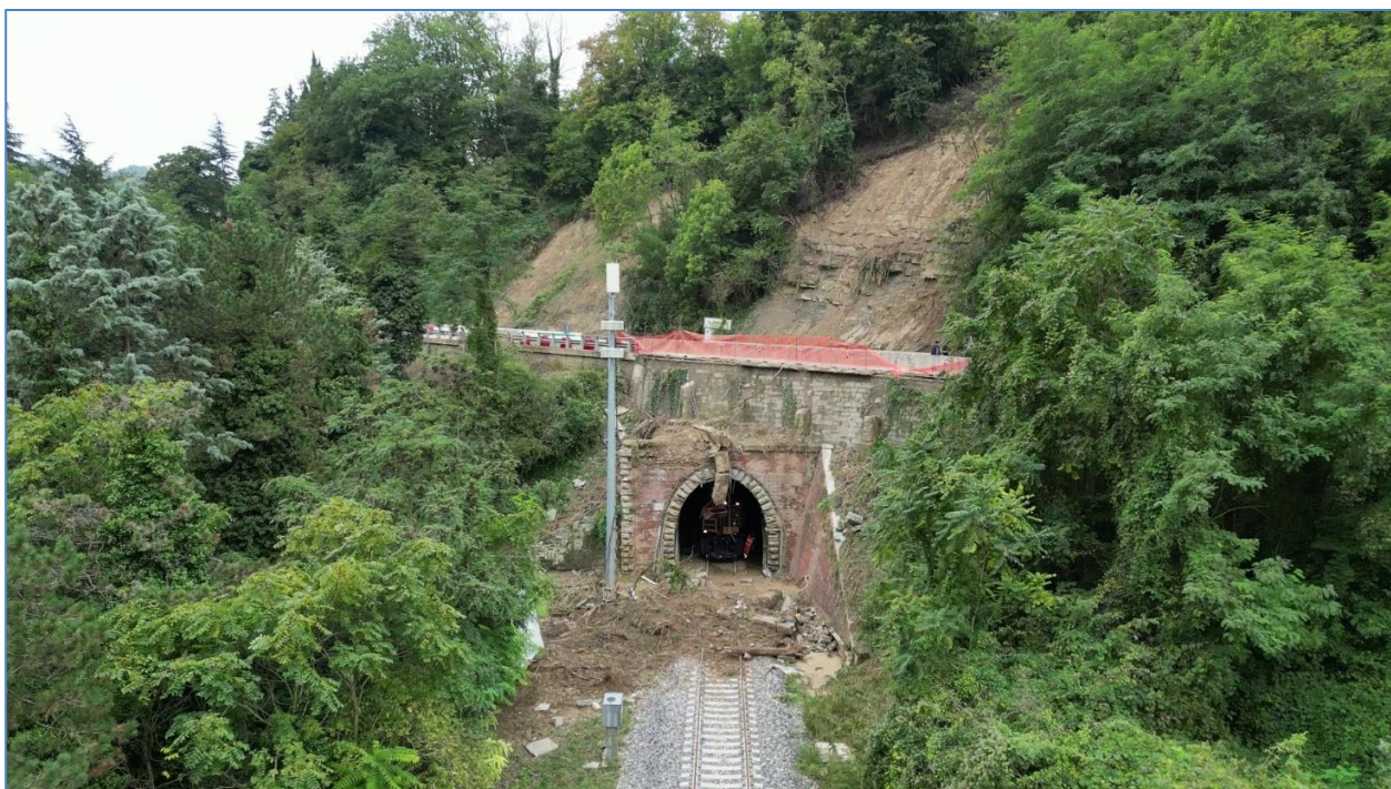
Figura 36: Scivolamento di terra che ha interessato contemporaneamente la SP 302R e la ferrovia Faentina nei pressi di San Cassiano sul Lamone (Brisighella – RA), località che ha registrato il massimo regionale di piogge per l'evento con oltre 350 mm.
