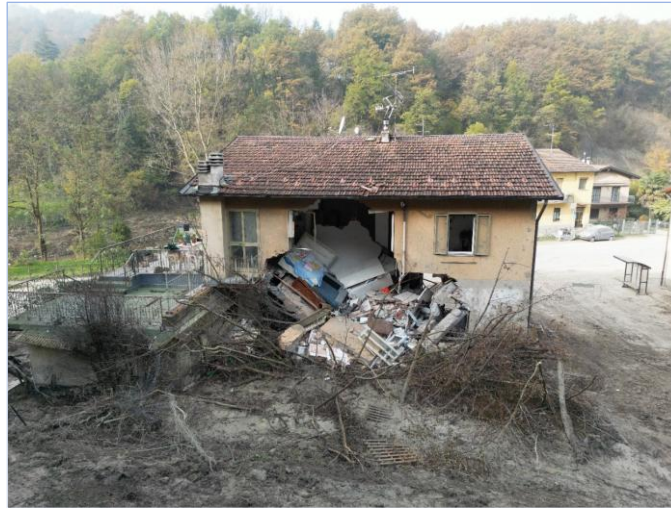
Figura 42: Abitazione colpita da una frana per scivolamento rapido di terra e detrito, lungo la strada di fondovalle Idice in località Monterenzio (BO).
