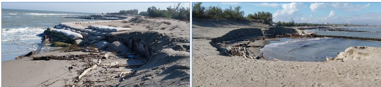
Figura 50: Erosione litorale con danneggiamento opera di difesa radente a Lido di Spina sud
