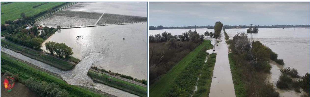
Figura 35: Allagamenti causati dalla rotta arginale del canale Savena abbandonato a Baricella (a sinistra, foto Il Resto del Carlino), e dalla rotta arginale del fiume Idice ad Argenta (a destra, foto Gazzetta di Reggio)
