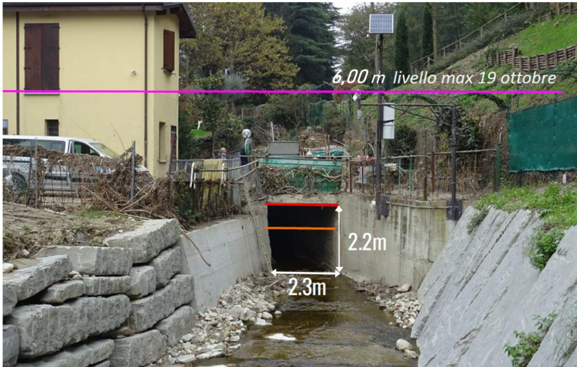
Figura 20: Idrometro di Ravone in Via di Ravone n°20, con l'indicazione del livello delle soglie rispetto alla sezione di imbocco della tombatura, e della traccia del rigurgito della piena sulla casa adiacente.
