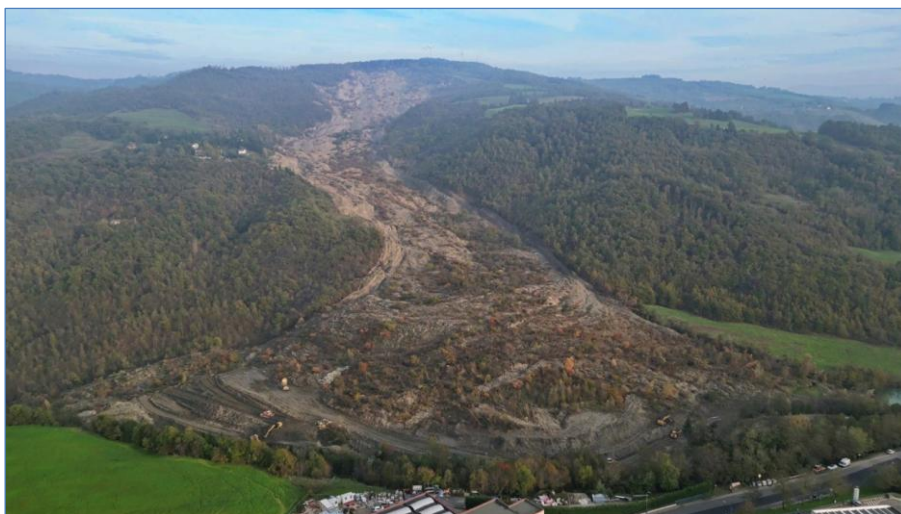
Figura 44: Vista panoramica sulla frana di Cà di Sotto (San Benedetto val di Sambro). Ripresa da drone del 08/11/2024.
