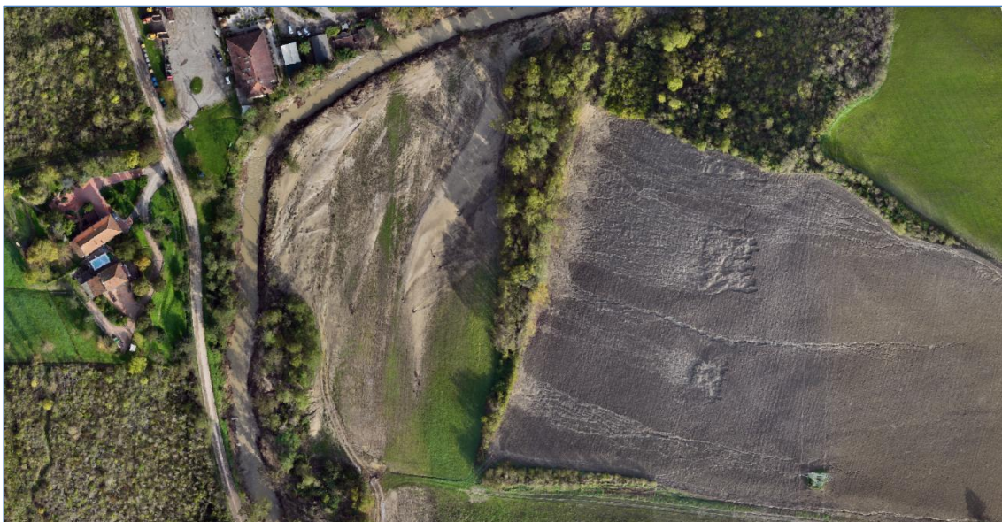
Figura 40: Fenomeni di ruscellamento lungo i versanti, erosione spondale ed esondazione del torrente Zena in località Lago dei castori, a sud dell'abitato di Botteghino di Zocca
