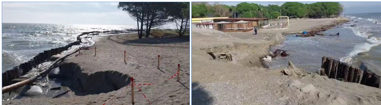
Figura 50: Erosione litorale con danneggiamento opera di difesa radente a Lido di Spina sud
