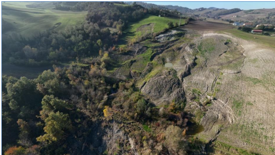
Figura 43: Frana di Cà della Torre – Loc. Quinzano (BO). Parte alta interessata dagli scivolamenti rototraslativi.
