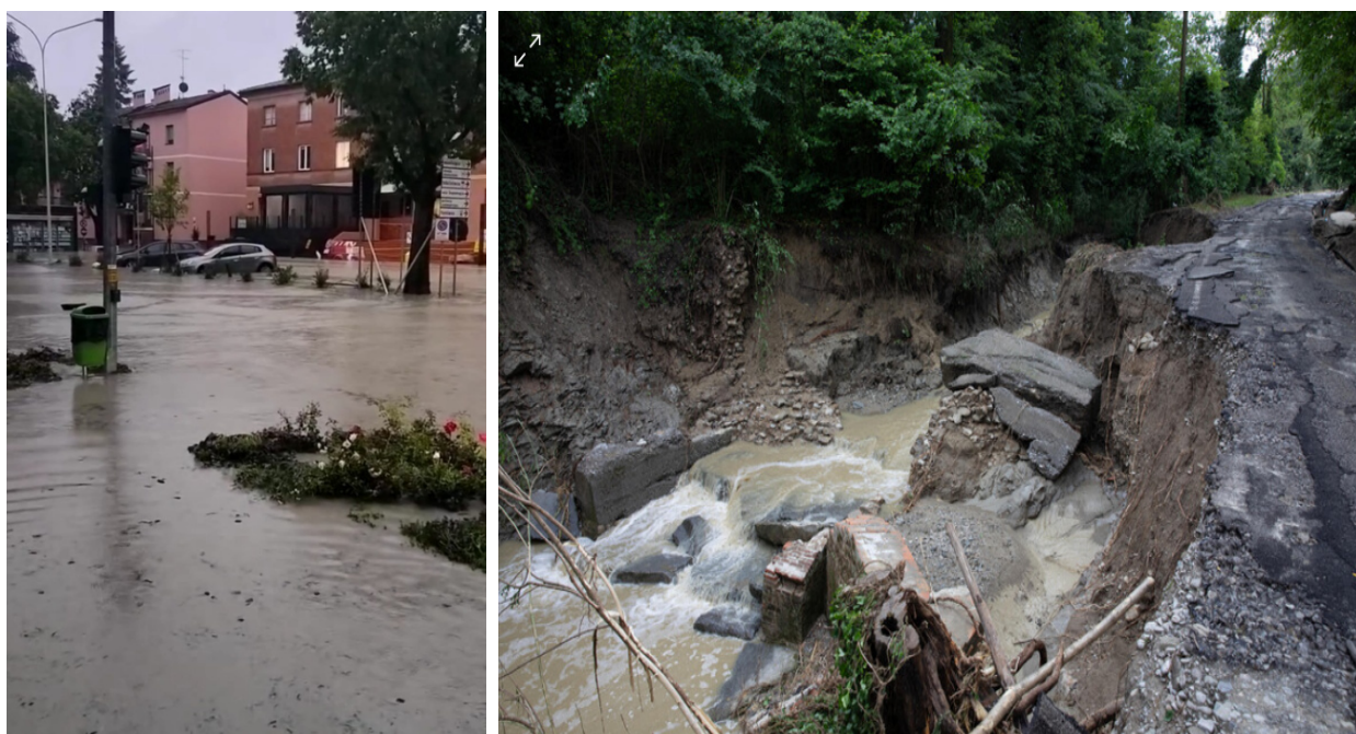
Figura 21: Allagamenti nella piazza di Monteveglio (BO) (fonte Emilia-Romagna meteo, a sinistra), erosione spondale sui Rio Marzatore ai danni della viabilità (fonte ANSA.it a destra)
