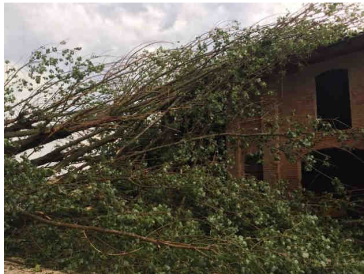
Figura 47. Albero caduto nell'imolese (BO) (fonte: il Resto del Carlino Bologna).
