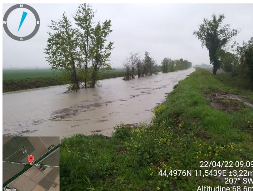
Figura 36: Piena del torrente Quaderna nel tratto arginato, in corrispondenza della SP253 S. Vitale
