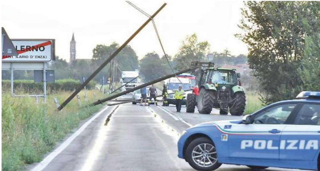
Figura 26. Pali della luce caduti a terra a Sant'Ilario d'Enza. Foto da Il Resto del Carlino.
