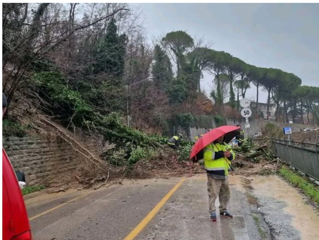
Figura 40: Frana per scivolamento della coltre detritica che ha occupato la sede stradale della SS67 nel comune di Dovadola (FC).
