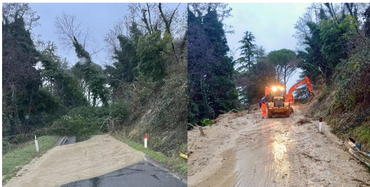
Figura 38: Frana per colamento che ha interrotto la SP33 nel comune di Fontanelice (BO).
