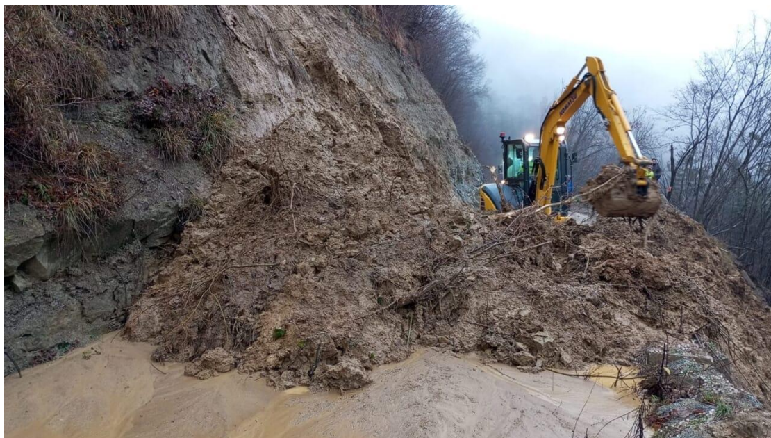
Figura 39: Frana per scivolamento della coltre detritica che ha occupato la sede stradale della SP86 nel comune di Tredozio (FC).
